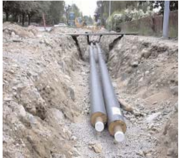
Två singelrör kräver bredare kulvert än ett tvillingrör.
