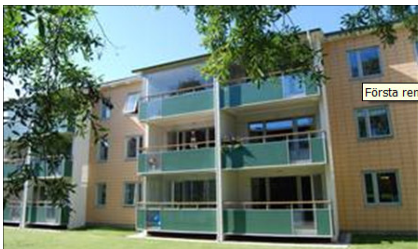
Figur 2.1 Kv Brogården Alingsås efter ombyggnad. Fullständigt utbyte av flera systemdelar: fasad, fönster och ventilationssystem
