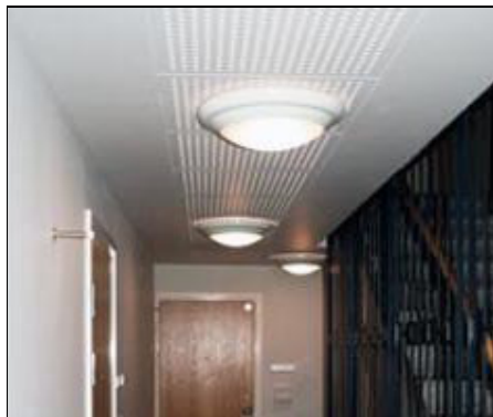
Figur 7.1. LED armatur för trapphus. Finns även med närvaroavkänning och tänd/släck- eller min/max-funktion för att slavstyra armaturer utan sensor. Armaturen ger ljus motsvarande 22 W kompaktlysör. Dimbar till 10% via driftspänning. Källa: Energisystem, Nyköping.
