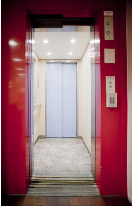
Figur 4.7. Hiss med närvarostyrd LED-belysning. Örebro Bostäder.
