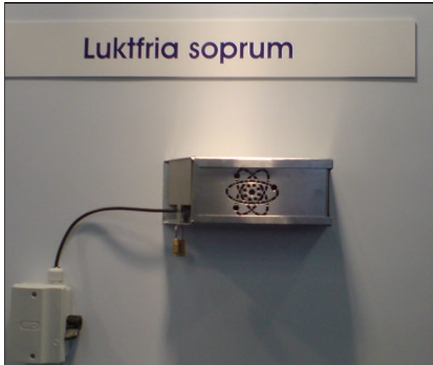
Figur 4.4. Lukteliminering med ozonrening kan vara ett kostnadseffektivt alternativ till utspädning med ökade luftflöden
