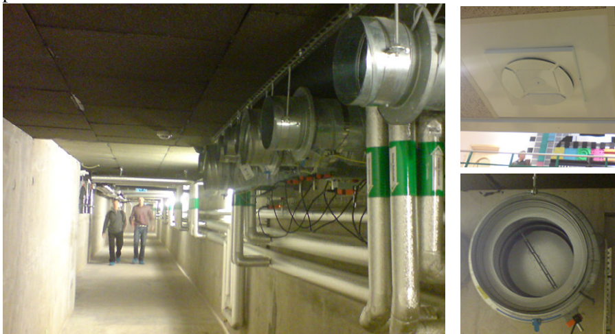
Tilluftskulvert under byggnation Luftflödet styrs utifrån rummets personbelastning. Till höger ses en stängd ventil till ett vid tillfället obemannat klassrum. Lilla bilden upptill visar ett av flera tilluftsdon. Dessa öppnas av trycket som uppstår då ventilen i kulverten öppnar.
