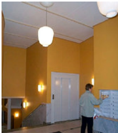
Trappbelysning Kv Tegelprämen
